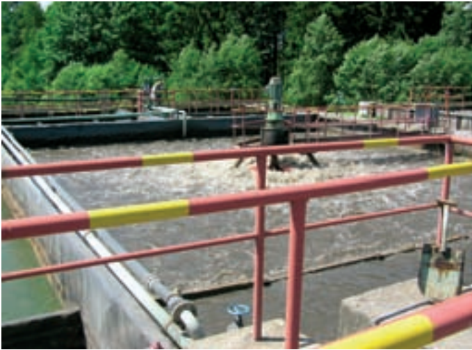
Obr. 3 a, b: Aktivační nádrž, prázdná dosazovací nádrž
