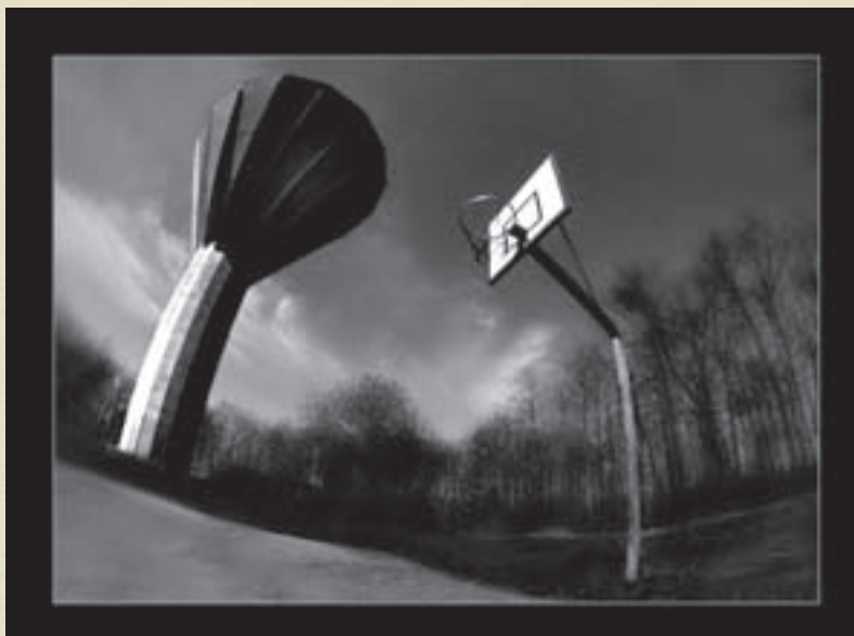
4. místo a čestné uznání: Zdeněk Prokop – Blíženci (vodojem Brno-Kohoutovice)
