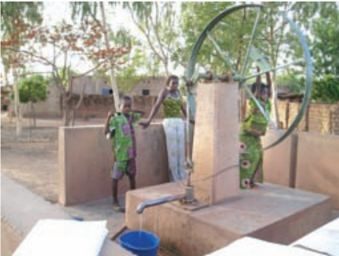
Obr. 2: Vrt s ručním čerpáním
