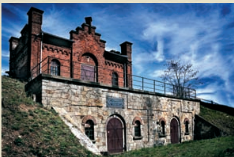
5. místo a čestné uznání: Marta Černická – Vodojem Homolka (vodárna Plzeň)
