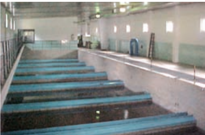
Obr. 1: ÚV Mariánské Lázně – filtrace před rekonstrukcí
