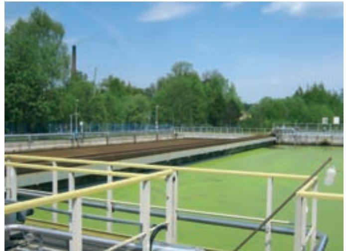
Obr. 2: Pohled na dosazovací nádrž pokrytou porostem okřehku
