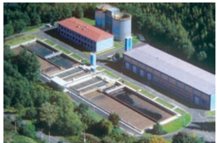
Obr. 1: Intenzifikovaná ČOV Aš před rekonstrukcí kalového hospodářství
