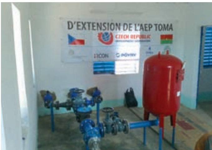
Obr. 5: Interiér provozního domku
