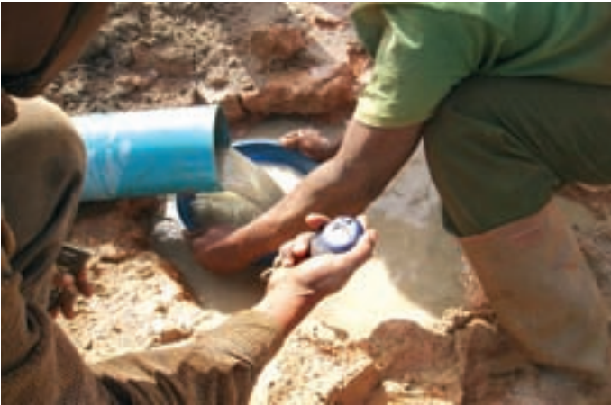
Obr. 4: Orientační čerpací zkouška
