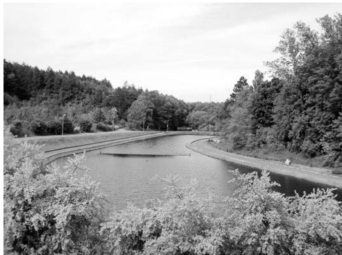
ČOV Dolní Chabry, dočišťovací nádrž – biologický rybník
