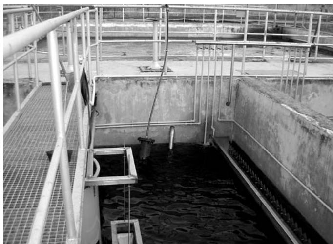
Detail řešení odtokových žlabů v dosazovacích nádržích
