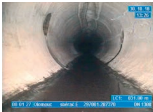
Obr. 4: Kamerová prohlídka opraveného sběrače
