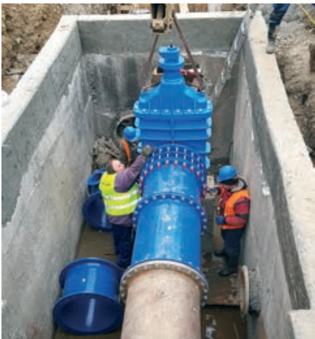
Nová šachta – instalace armatur DN 700
