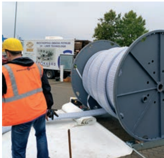
Zatahování vložky PrimusLine DN 500
