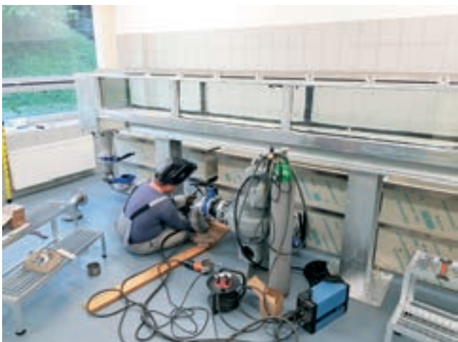
Obr. 5: Montáž potrubí hydraulického okruhu
