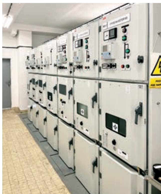
Výměna rozvaděče v rozvodně 6,3 kV
