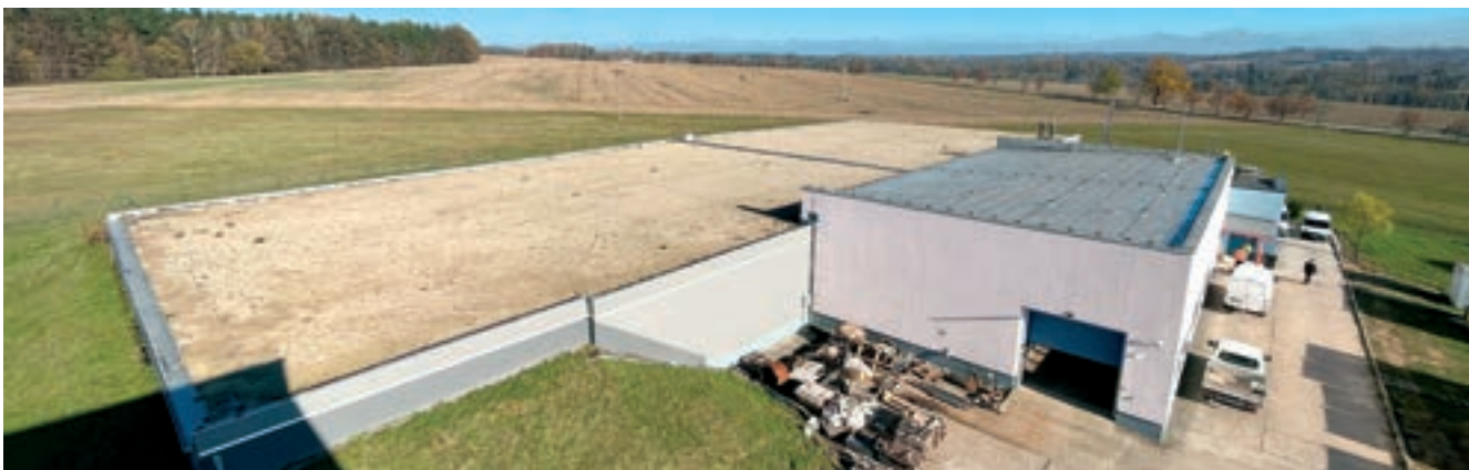
Čerpací stanice Hosín II – pohled na akumulční nádrže a armaturní komoru
