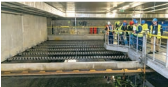
Závěrečným bodem programu byla exkurze na Nové vodní lince ÚČOV Praha
