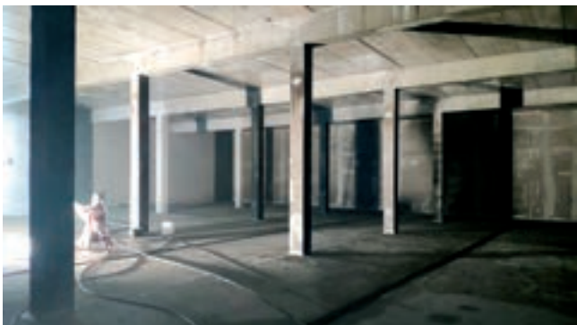
Sanace betonových konstrukcí akumulční nádrže o objemu 6 000 m 3
