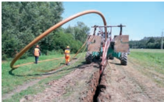
Kanalizační přivaděč JIH, pluhování potrubí d 180 mm
