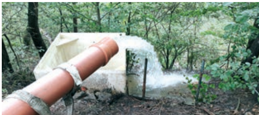
KL 5A, čerpací zkouška 20 l/sec
