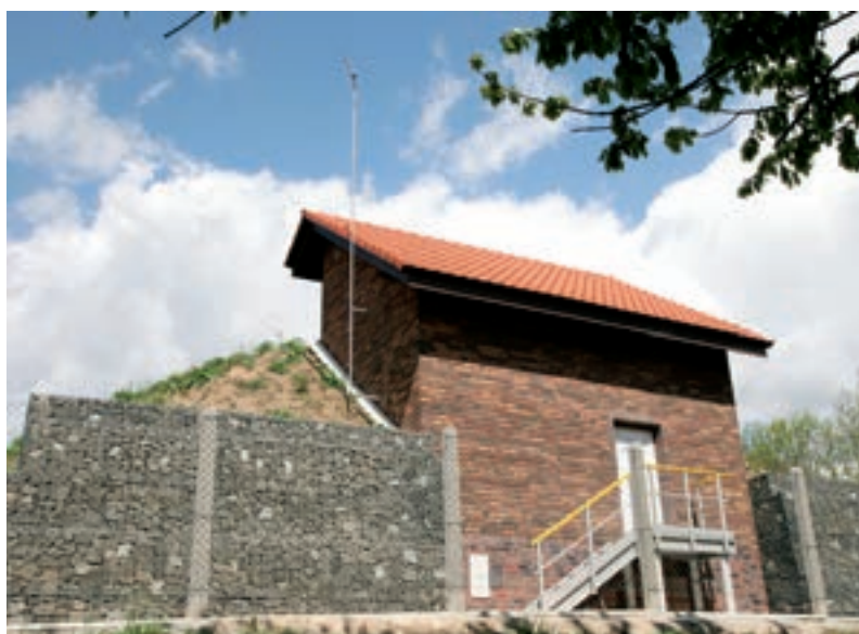
Vodojem Horní Stakory
