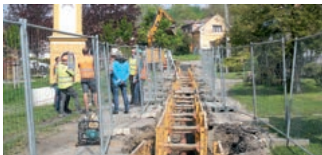
Úherce výstavba kanalizace, stoka A2
