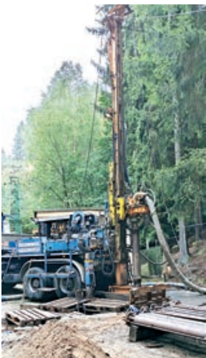
KL 6A, práce vrtné soupravy
