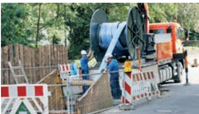
Vložka Primus Line® se transportuje v návinech na cívkách. Cívka je schopna pojmout až 1 675 m DN 500 a až 5 700 m DN 150
