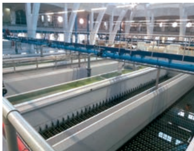
Obr. 3: Modernizace ÚV Podolí v roce 2019–2021 minulého století (doplňování sorpčního stupně)
