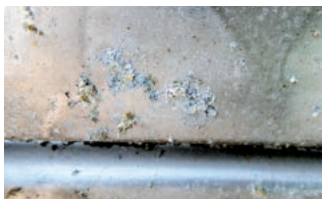
Obr. 5: Stav PKO na ocelových konstrukcích a hliníkových plechů v hale hrubého předčištění
