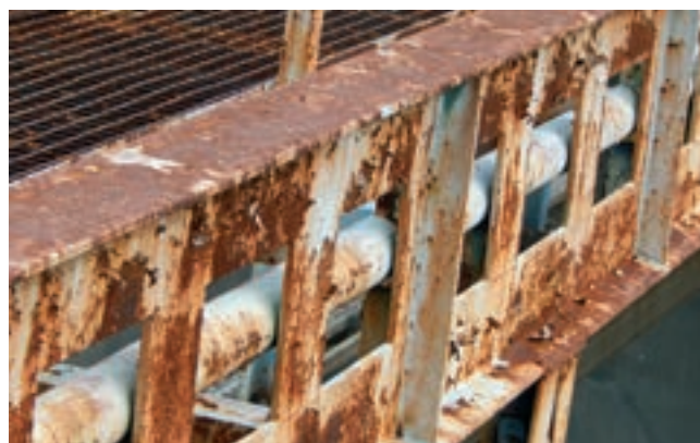
Obr. 4: Stav protikorozní ochrany (PKO) na ocelových konstrukcích nad usazovacími nádržemi
