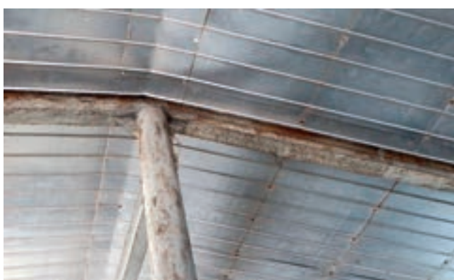
Obr. 5: Stav PKO na ocelových konstrukcích a hliníkových plechů v hale hrubého předčištění
