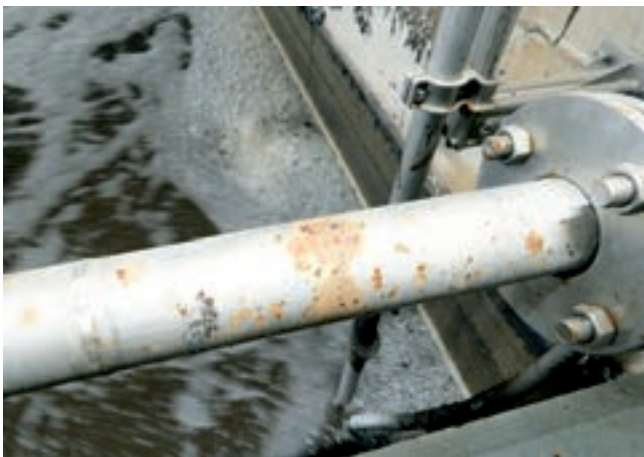
Obr. 12: Korozní napadení nad dosazovacími nádržemi ve vnitřním prostředí
