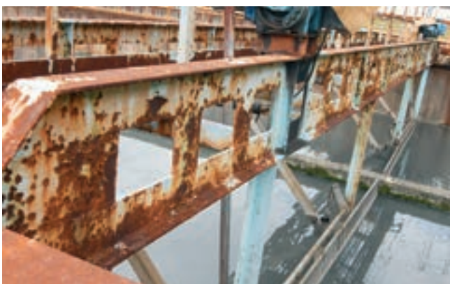
Obr. 4: Stav protikorozní ochrany (PKO) na ocelových konstrukcích nad usazovacími nádržemi
