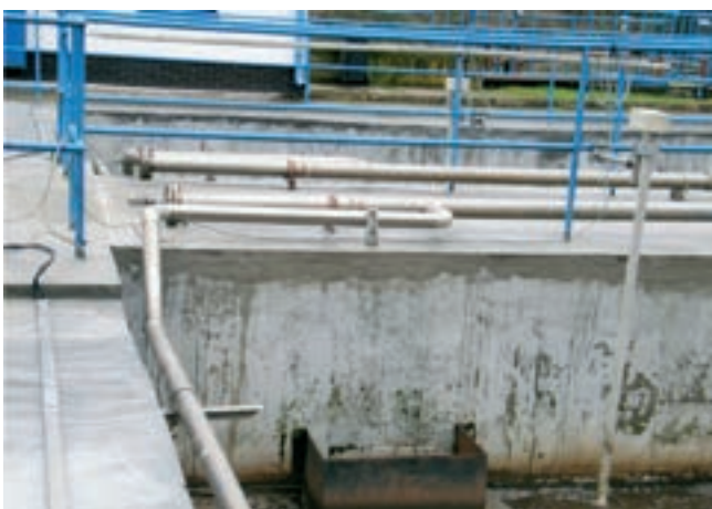
Obr. 13: Korozní napadení nad nádržemi ve vnějším prostředí
