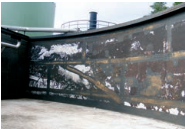
Obr. 9: Stav poškození PKO v usazovací nádrži po třech letech expozice
