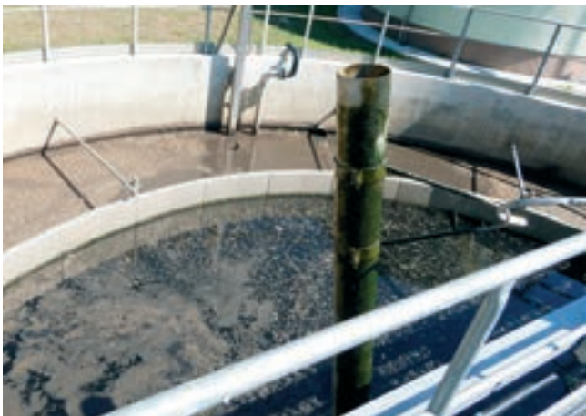
Obr. 10: Stav poškození hliníkové slitiny dosazovací nádrže po čtyřech letech expozice
