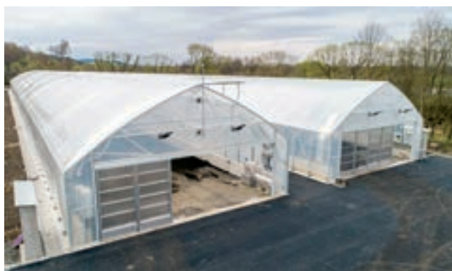
Obr. 7: Čelní pohled na solární sušárny ze strany vstupu odvodněného kalu
