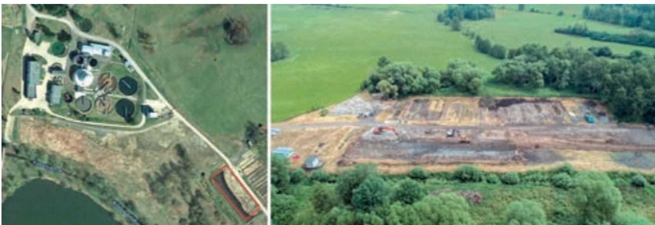
Obr. 1: Umístění a staveniště solární sušárny Mariánské Lázně
