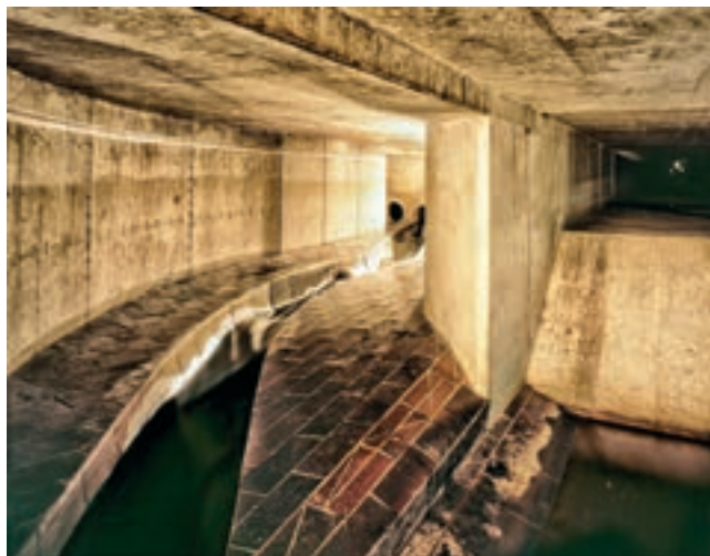
Odlehčovací komora pod ulicí Vlhká
