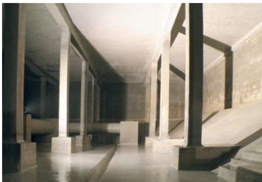
Vodojem Palacký vrch
