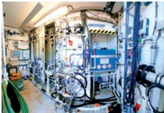
Obr. 4: Kontejner pro technologii doupravy zavlažovací vody tvořené odtokem z NVL ÚČOV
