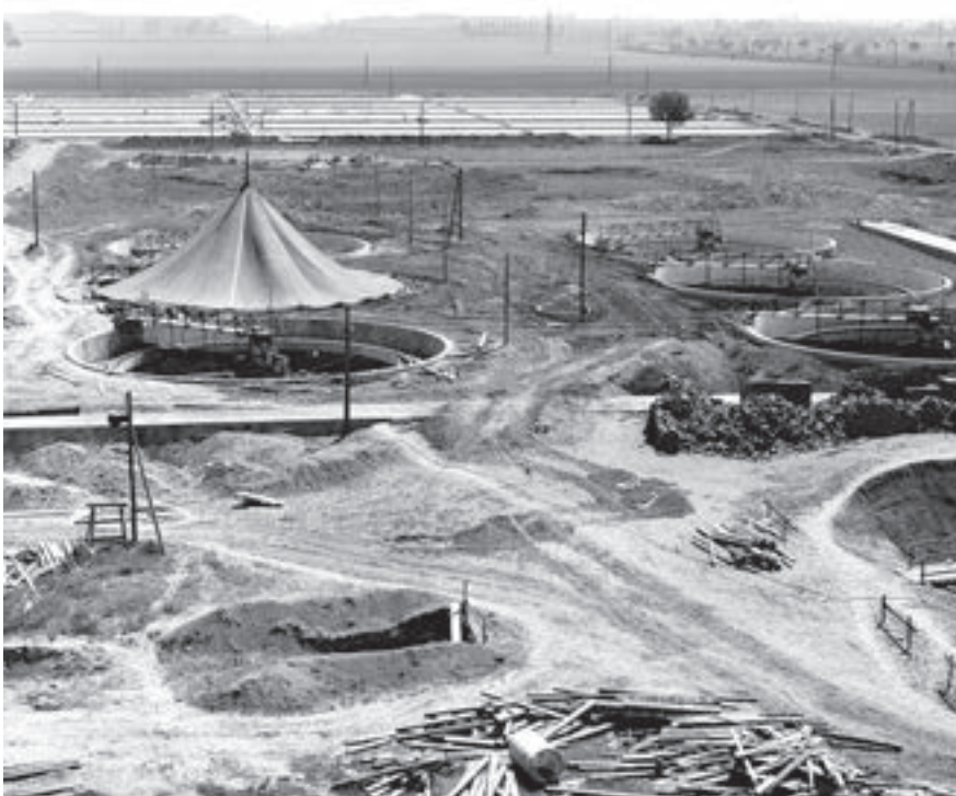
ČOV Modřice – výstavba dosazovacích nádrží v roce 1956
