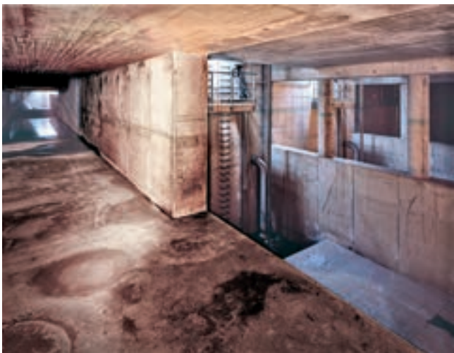
Retenční nádrž Sokolova
