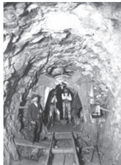
Stavba I. březovského vodovodu – Novohradská štola
