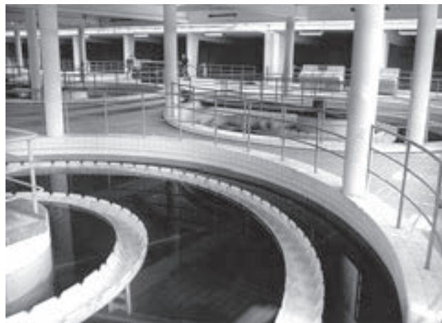
Úpravna vody III. Brno-Pisárky – hala čičičů
