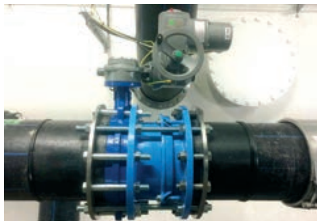
CEREX 300 W Uzavírací klapka, ovládaná elektrickým servopohonem
