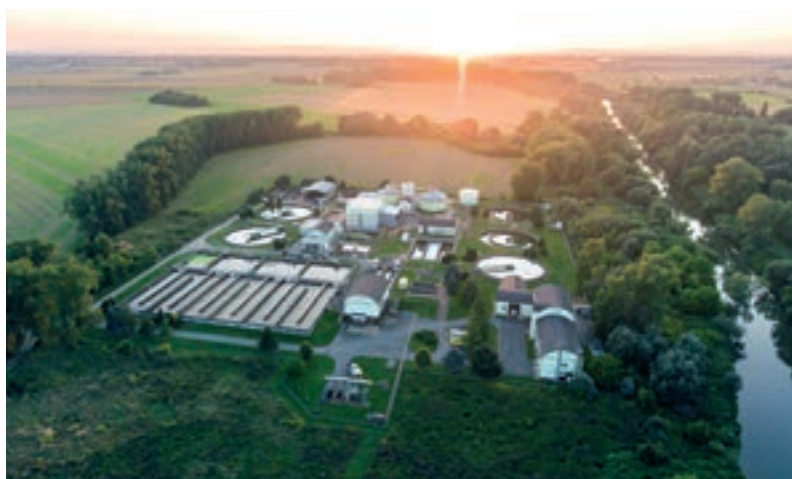
Celkový pohled na objekt nízkoteplotního sušení kalů na ČOV Přerov
