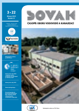
Objekt nízkoteplotního sušení kalů na ČOV Přerov
