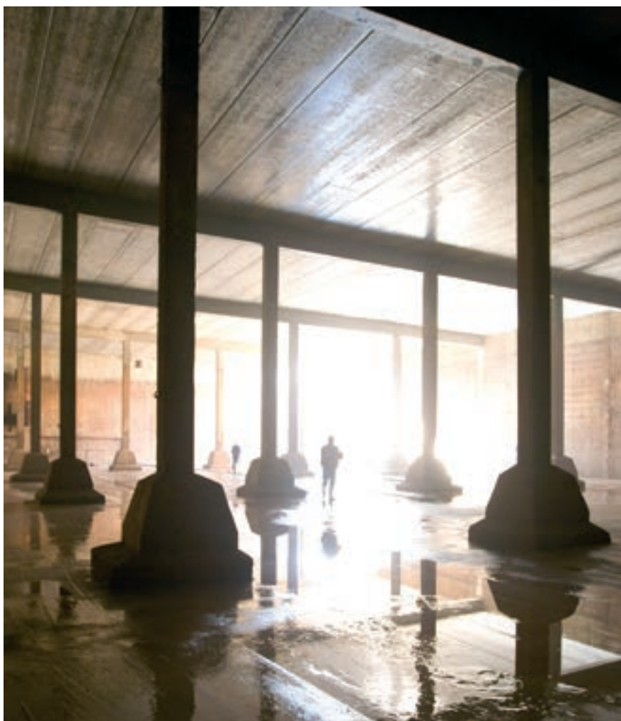
Zemní vodojem Kožova hora – pohled do jedné z akumulčních komor
