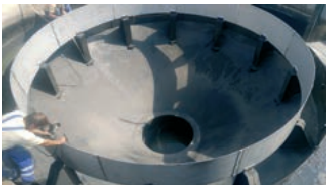
Obr. 1: Pohled na vypuštěný rozdělovací objekt s nornou stěnou [1]
