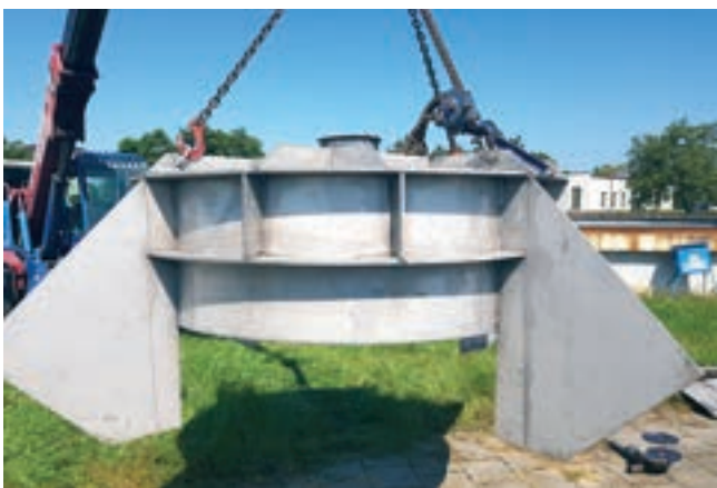
Obr. 7: Usměrňovací prvek připravený k instalaci
