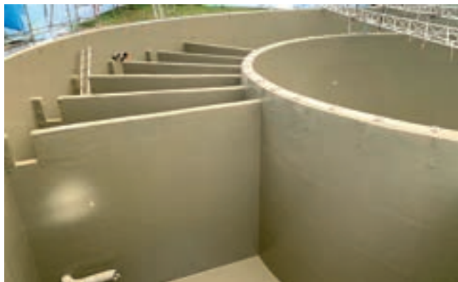
Aktivační nádrž v ČOV Tanvald po aplikaci systému MasterSeal 7000 CR (2019). Zdroj: Severočeská servisní a. s.
