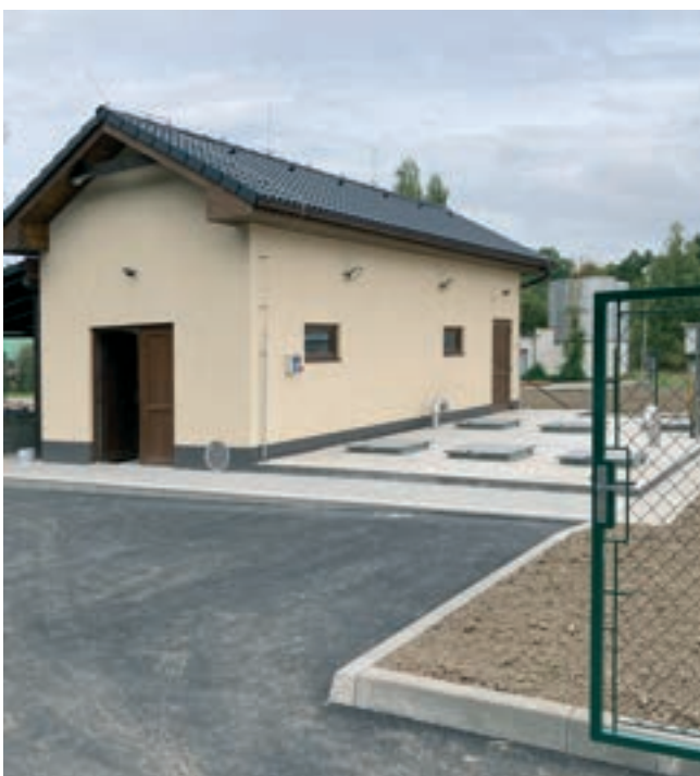
Obr. 4: Objekt nové čerpací stanice
