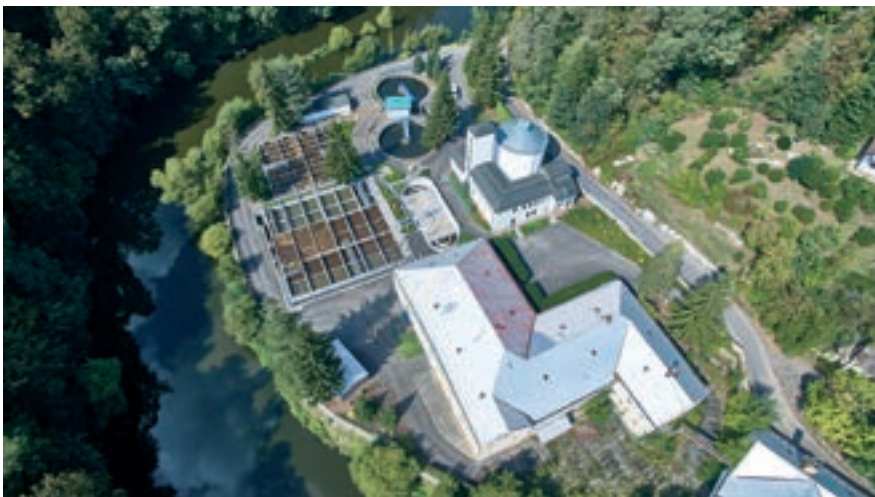
Letecký pohled na ČOV Klokoty
