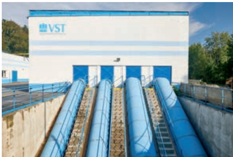
Areálová čistírna odpadních vod Táboř
