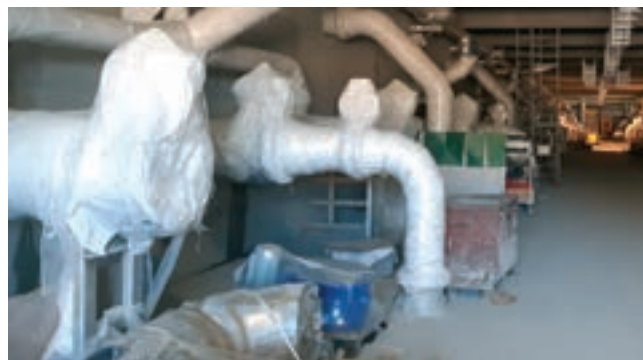
Obr. 13: Ochrana potrubí během stavby
