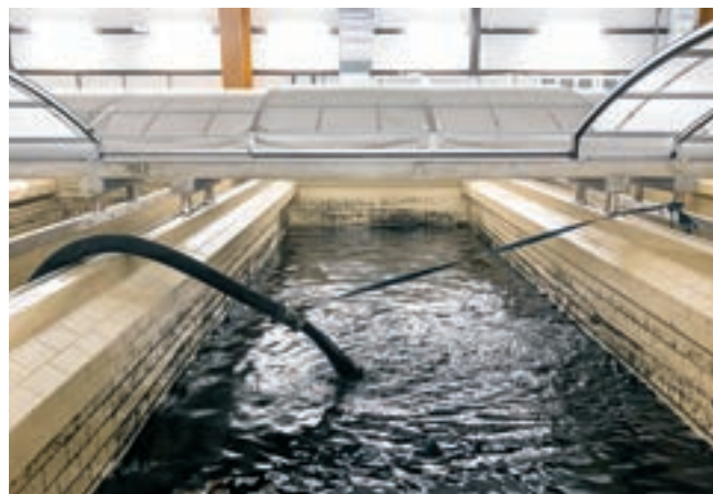
GAU, doprava materiálu do filtru hydraulickou cestou
