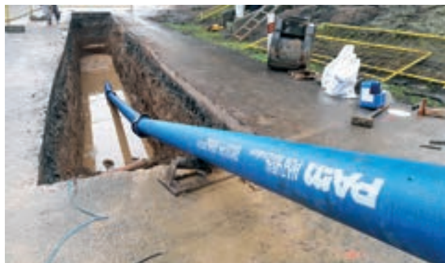
Obr. 2. Potrubí UNIVERSAL Ve DN 150 mm NATURAL-BioZin-alium® PUR, instalace potrubí na povrchu s využitím úhlového odklonění ve spojích
