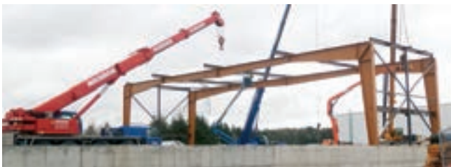
Obr. 2: Počátek montáže – výsledné řešení hlavních rámi
