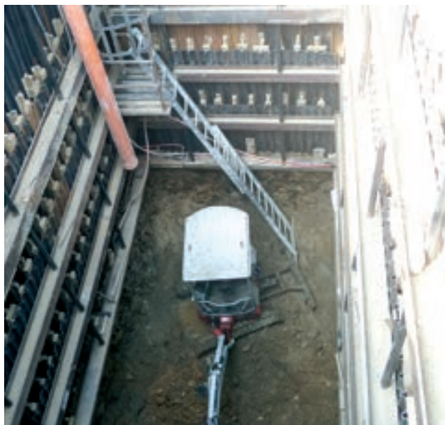
Obr. 5: Ražba a dočasné vystrojení šachty a štoly nátokového objektu
