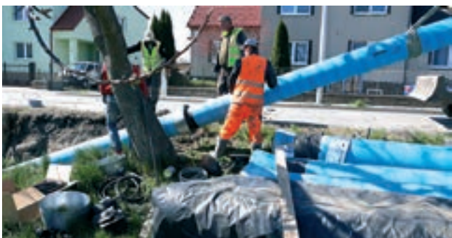
Obr. 1: Trubky se spojem UNIVERSAL Ve DN 300 mm DIRECTIONAL® ZMU, montáž potrubí na povrchu
