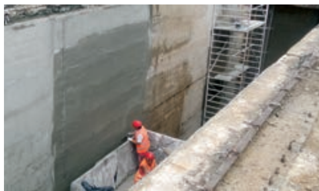
Obr. 8: Obtokový kanál – stav betonu po preparaci VVP; finální hlazení plošné reprofilace
