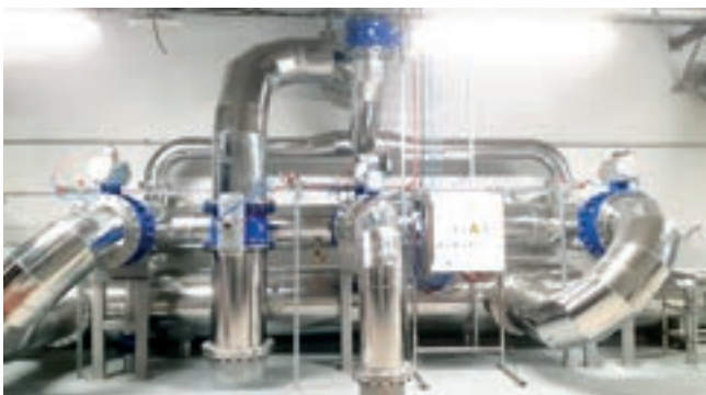
Obr. 12: Pohled na čelo filtru
