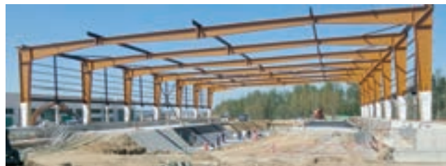
Obr. 3: Úplná soustava hlavních rámi a práce pod nimi
