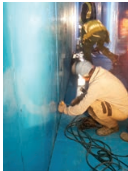
Obr. 7: Vystýlka v rozdělovacím kanálu – finální extruzní svařování
