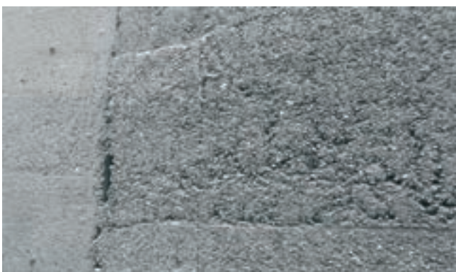
Obr. 8: Obtokový kanál – stav betonu po preparaci VVP; finální hlazení plošné reprofilace
