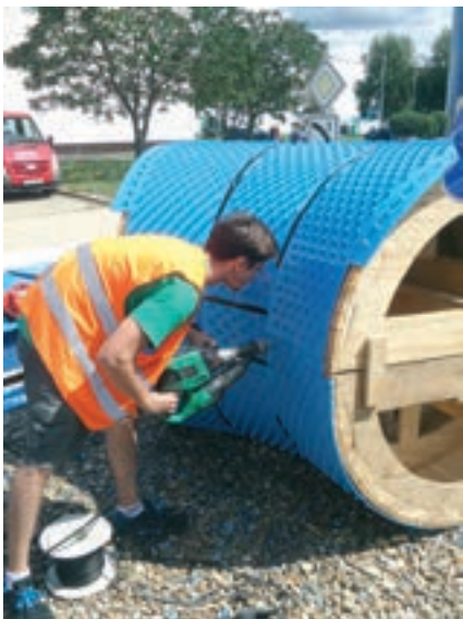
Obr. 6: Vystýlka spadiště – příprava segmentového kolena, finální osazení při betonáži
