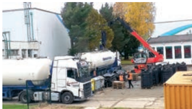
GAU, přesypání materiálu do cisterny
