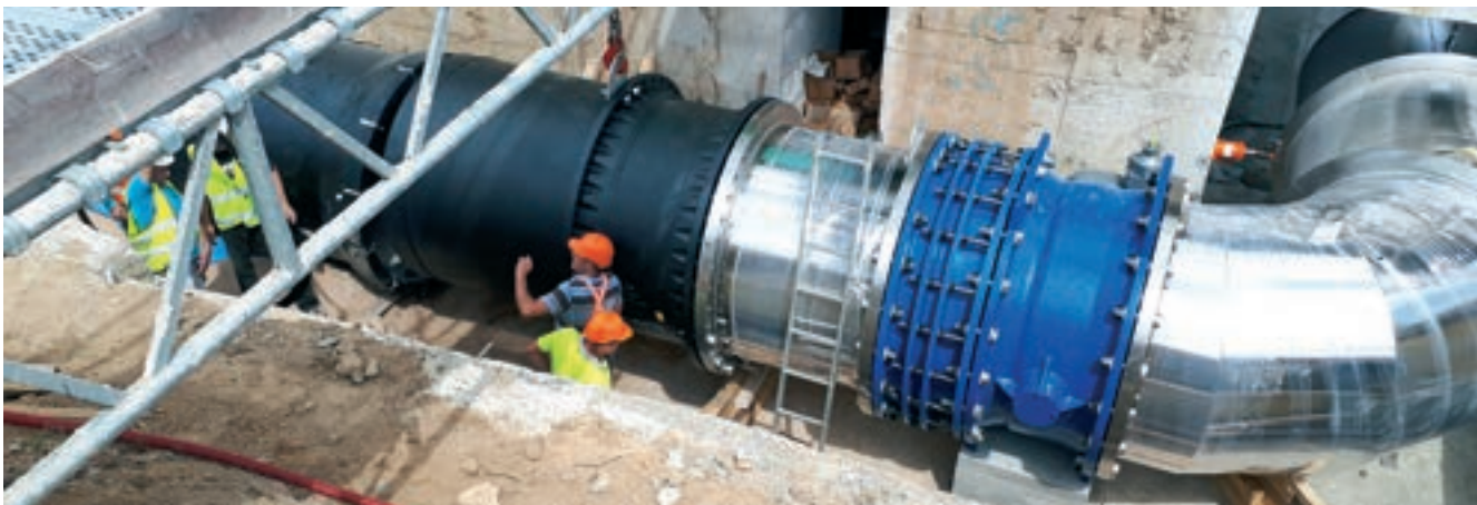
Spojovací potrubí, montáž sestavy vypínací komory na potrubí sání na PČS, litina, nerez DN 1 600
