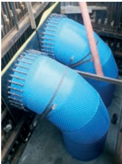
Obr. 6: Vystýlka spadiště – příprava segmentového kolena, finální osazení při betonáži
