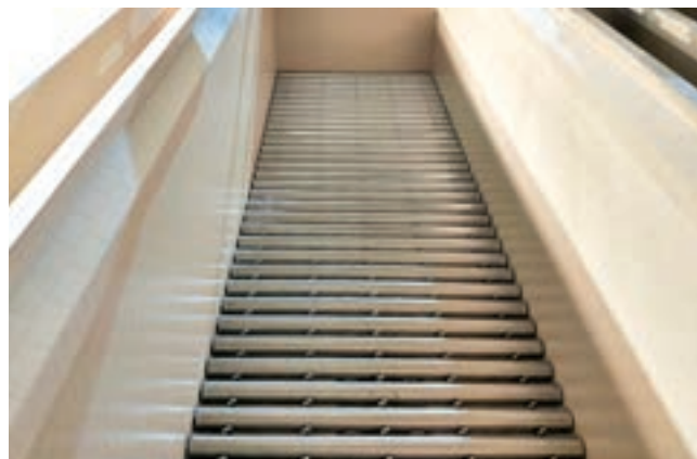
Obr. 2: Drenážní systém na dně filtru
