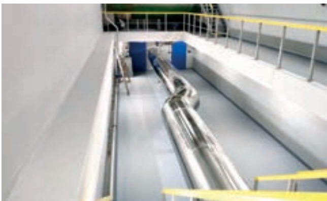
Obr. 10: Kolektor – trubní část – s napojením na objekt filtrace F2
