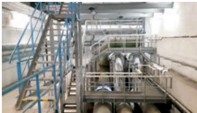
Obr. 9: Napojení přívodu prací vody pro GAU filtraci na stávající rozvody ve Filtraci F2
