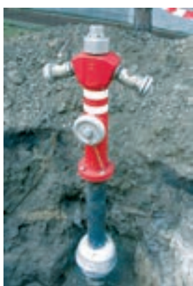
NOVA Nadzemní hydrant DN 100 s drenážním blokem
