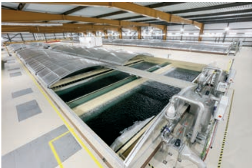
Obr. 5: Pohled do haly s 16 filtry GAU s programem bazénového zakrytí filtrů
