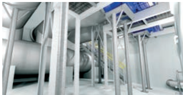
Obr. 6: Potrubí DN 2 400 umožňující obtok ozonizace (vizualizace)
