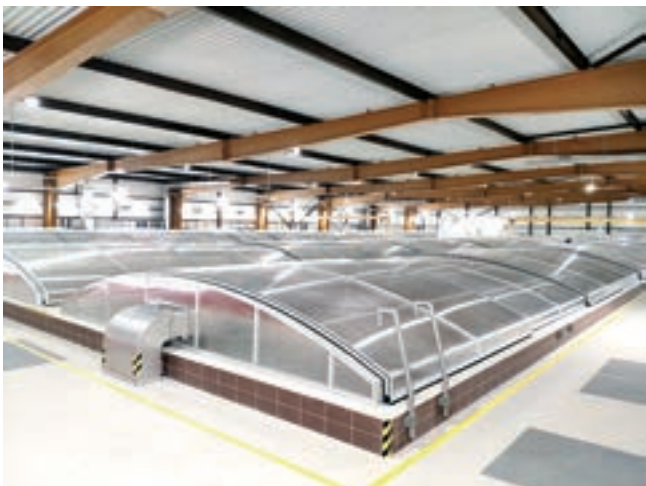
Obr. 3: Polykarbonátový kryt jednotlivých van filtrů
