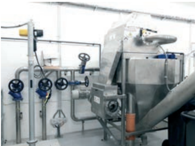
ČOV Dobroslavice – integrované hrubé mechanické předčištění
