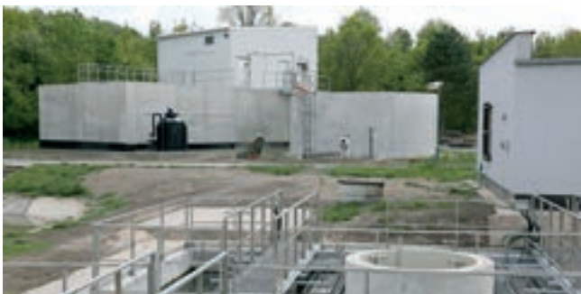
Rekonstrukce a intenzifikace komunální ČOV
