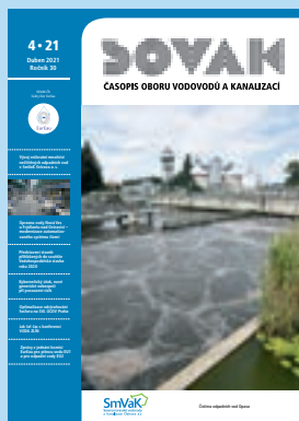
Čistírna odpadních vod Opava
