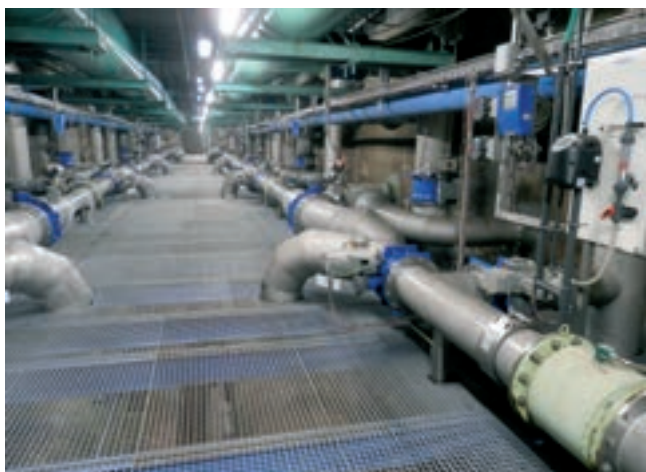
Obr. 2, 2a: Armaturní chodba pod halou filtrů
