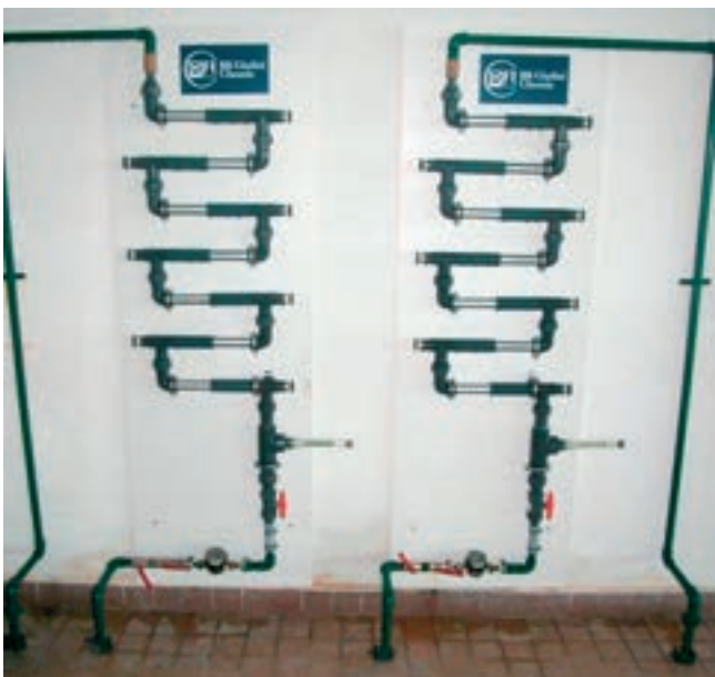
Obr. 2: Instalace korozních smyček na ÚV Březová
