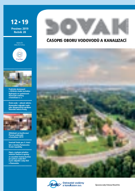
Úpravna vody Ostrava-Nová Ves
