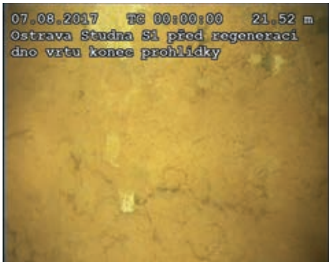
Stav zanesení perforace studny S1 před a po její regeneraci metodou Hydropuls v obdobné hloubce (21,52–21,69 m)
