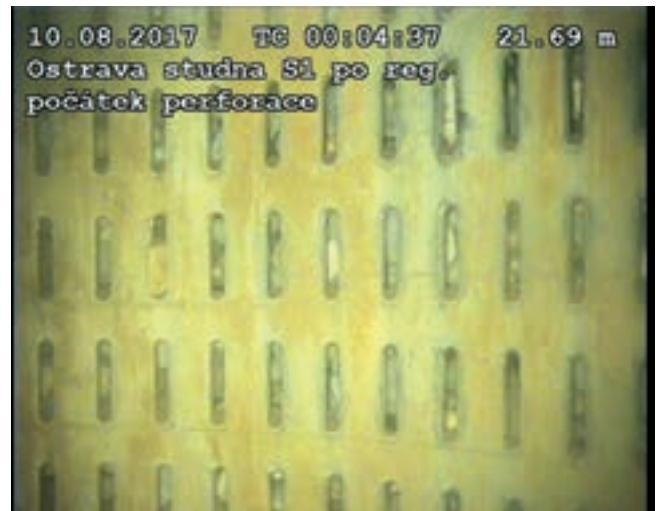
Stav zanesení perforace studny S1 před a po její regeneraci metodou Hydropuls v obdobné hloubce (21,52–21,69 m)
