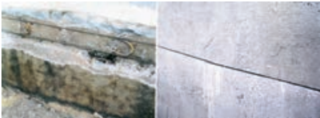
Obr. 2: Styk stropu a stěny vodojemu – původní stav vlevo, po opravě vpravo
