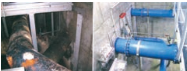
Obr. 4: Pohled do armaturní komory před (vlevo) a po sanaci (vpravo)
