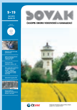
Vodárenská věž Dobruška. Válcový věžový vodojem vysoký 25 m s obsahem 250 m 3 . ČEVAK a. s.
