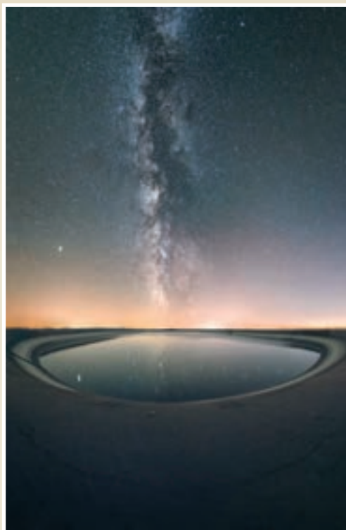
Martin Kotas: Přečerpávací vodní elektrárna Dlouhé stráně snímek z fotosoutěže VODA 2019
