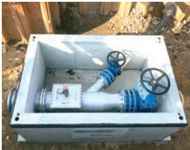
Prefabrikovaná šachta včetně armatur
