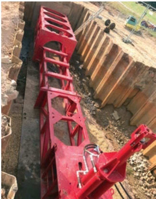
Obr. vlevo: Cílová jáma s technikou
