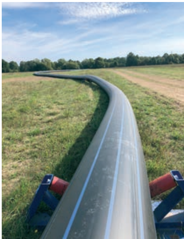
Předem svažené potrubí pro relining bez mezikruží
