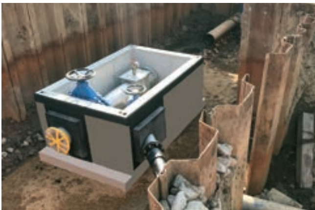
Napojení prefabrikované šachty
