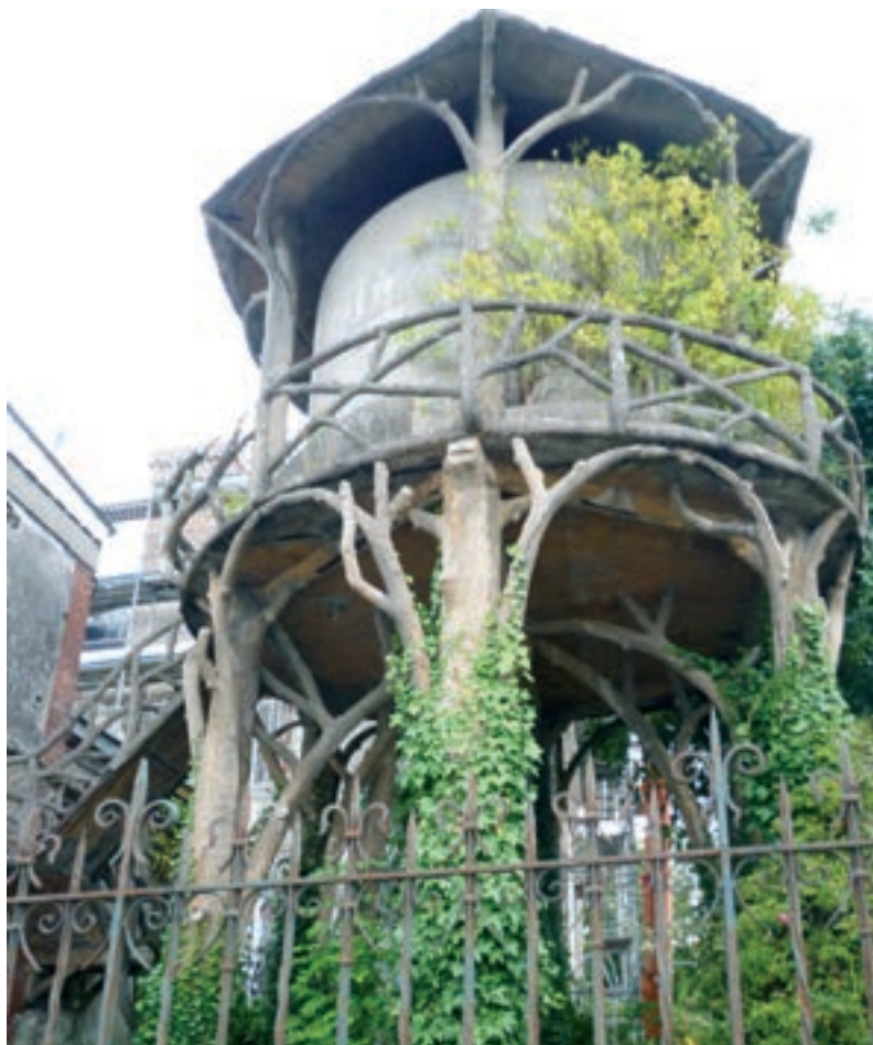
Stromový vodojem v normandském městě Pontorson, červenec 2018. Foto: Jaroslav Jásek
