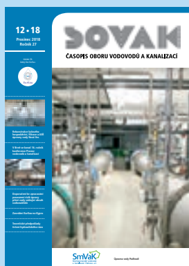
Úpravna vody Podhradí
