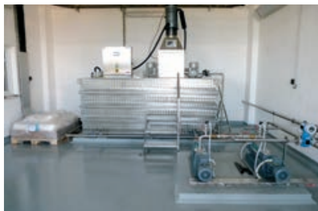
Odstředivka – flokulační stanice
