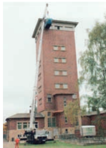
Obr. 4: Památkově chráněný plášť o výšce 40 m přinesl vysoké požadavky na logistiku
