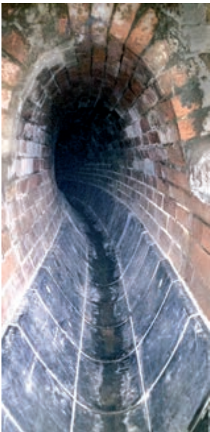
Realizovaná sanace, ulice Zenklova v Praze 8
