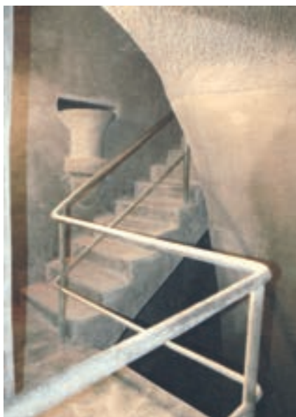
Obr. 6: Samotné vestavby byly ochráněny před korozi čistě minerálně. Zde je přepad a schodiště přístupu do vodní komory
