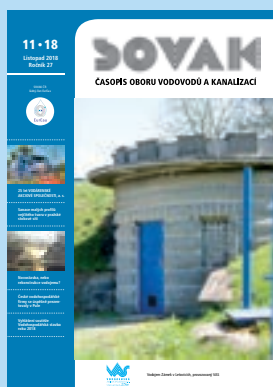
Vodojem Zámek v Letovicích
