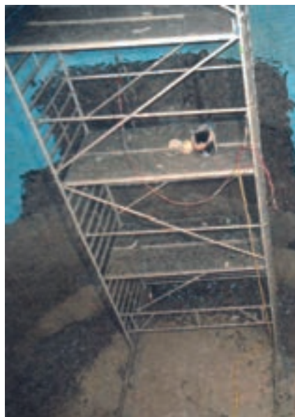
Obr. 3: Skutečný a detailní stav stavby se ukázal teprve po úpravě dna otryskáním vysokotlakým vodním proudem. V současné době by takový beton již nebyl pro tento účel přípustný
