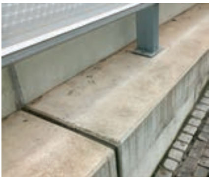
Obr. 7: Detail prefabrikátu pro ukotvení konstrukce skleníku a pojezd prohrabávacího mechanismu včetně podélné nasávací clony
