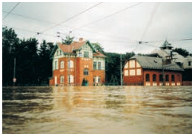
Obr. 13: Pohled z roku 1997 na zaplavený areál úpravy vody z křižovatky silnic 28. října a Plzeňská
