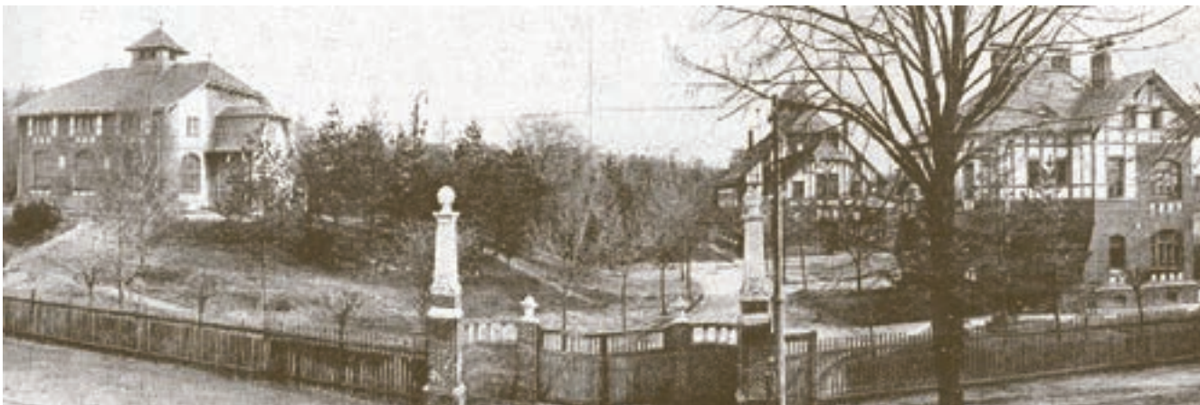
Obr. 4: Vzhled areálu vodárny z roku 1908 z pohledu křižovatky silnic 28. října a Plzeňská
