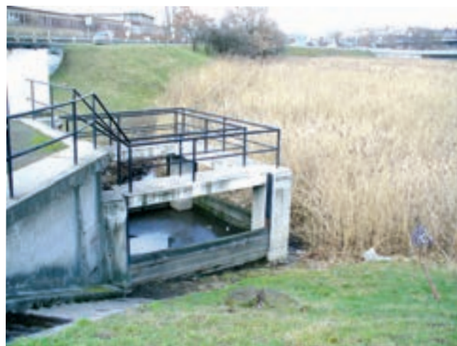
Obr. 4: Odtok ze současné nádrže Červený mlýn – na obrázku je patrné znečištění v okolí odtokového objektu
