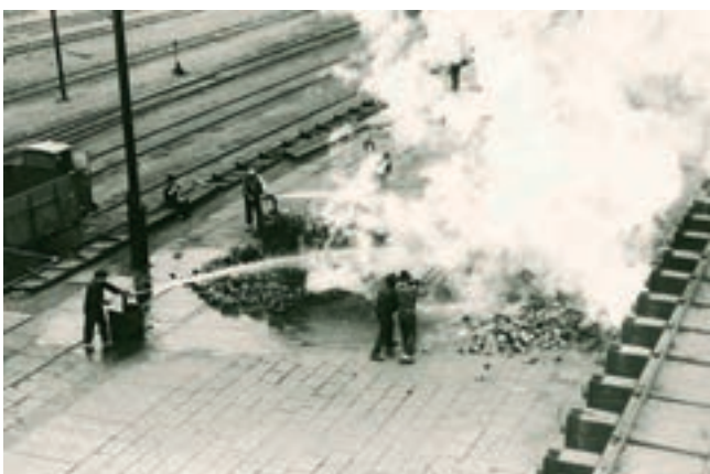
Obr. 1: Ruční hašení a trhání koksu na koksovně Hohenegger, nedatováno (zdroj: Archiv OKD)
