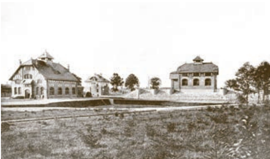
Obr. 3: Areál vodárny v Ostravě-Nové Vsi v roce 1908
