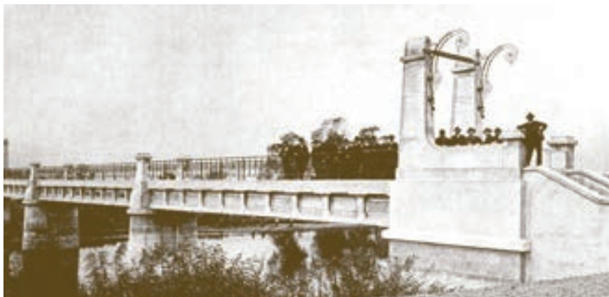
Obr. 7: Lávka přes Ostravici s potrubím z ÚV Nová Ves do Muglina kolem roku 1908
