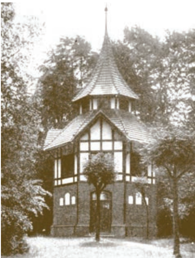
Obr 5: Sběrná studna na jímacím systému
