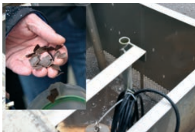
Obr. 6: SBR EAWAG v Niederglatt (Švýcarsko), koš pro separaci nosičů (vlevo), nosiče pro účinnější akumulaci mikroorganismů anammox (vpravo)
