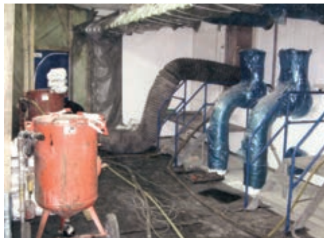
Obr. 3: Odkryté části zařízení
