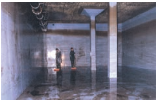
Obr. 1: Vodojem (rok výstavby 1972) byl původně vyložen umělohmotnou fólií
