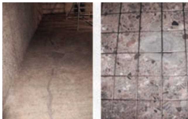
Obr. 4: Prasklina v potěru a dutina
