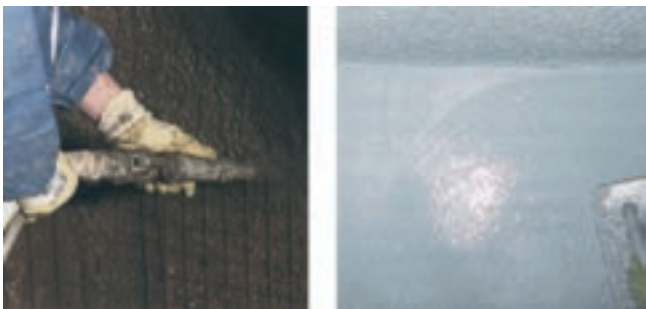
Obr. 6: Nástřik ocelových mřížek
