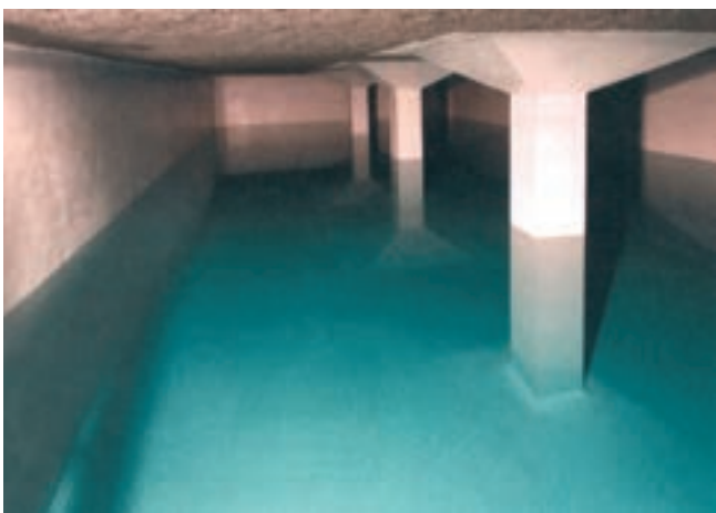
Obr. 10: Pohled do nitra vodojemu
