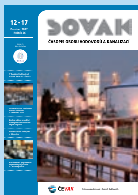
Čistírna odpadních vod v Českých Budějovicích
