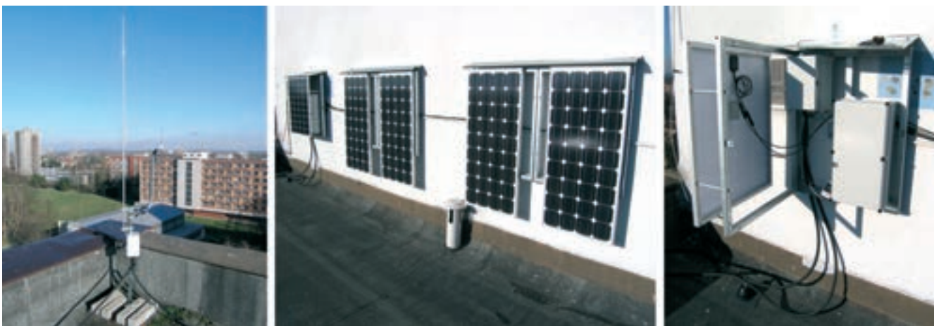
Obr. 5: Anténa vysílače, přijímač se solárními panely, detail přijímače
