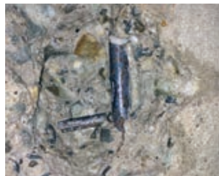
Obr. 3: Sekaná sonda
