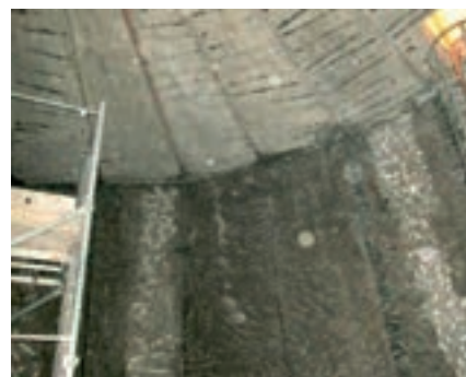
Obr. 11: Zatékání mezi stropními panely a na styku stropu a stěn
