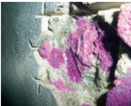
Obr. 6: Zkouška karbonatace fenolftaleinem
