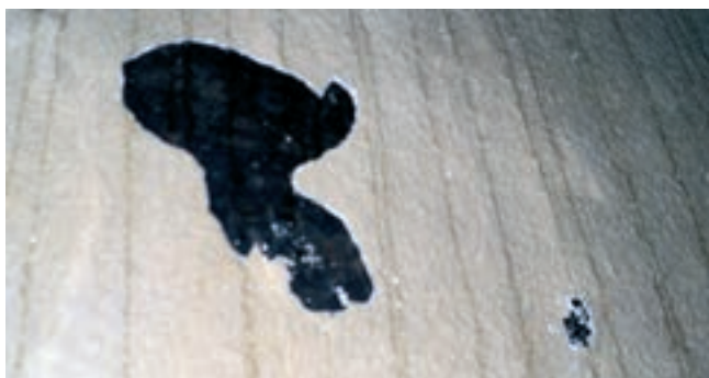
Obr. 9: Důsledek neodstranění napenetrované vrstvy pod odstraněným bitumenovým nátěrem
