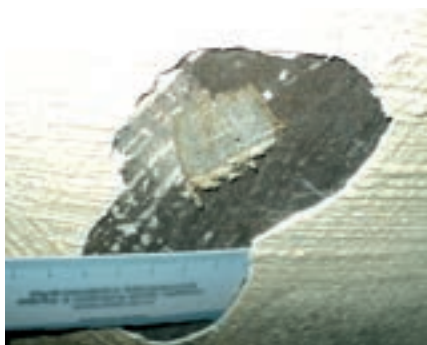
Obr. 10: Orientační měření mocnosti aplikovaných vrstev
