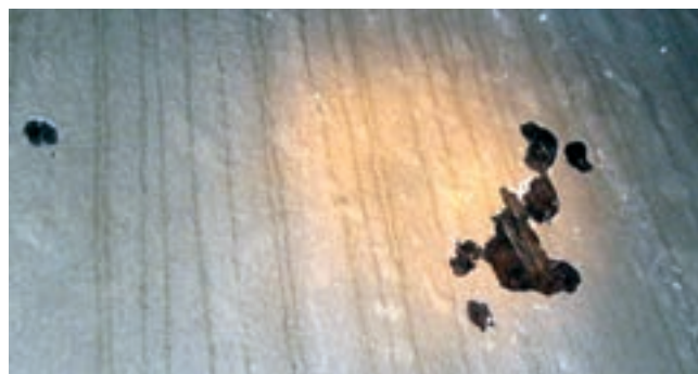
Obr. 9: Důsledek neodstranění napenetrované vrstvy pod odstraněným bitumenovým nátěrem
