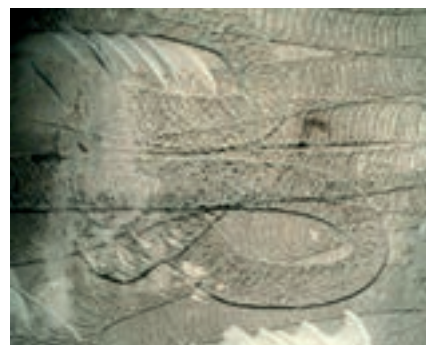
Obr. 5: Výsledek nedostatečně odstraněné zdegradované vrstvy
