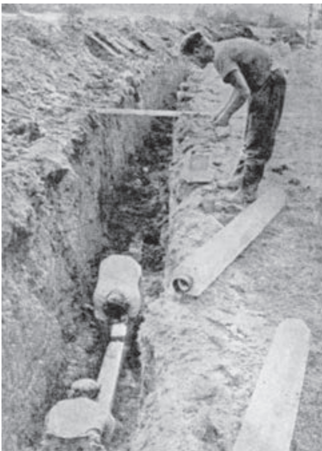
Obr. 1: Pokládka sklobetonového potrubí [1]
